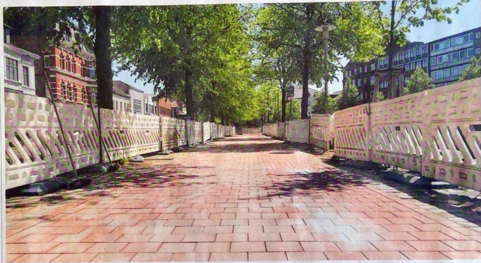
Die neue Pflasterung des Großflecken-Radweges nimmt Form an.
